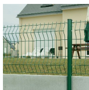
Pose avec plaque de soubassement
