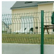
Pose avec plaque de soubassement
