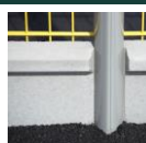
Pose avec plaque de soubassement
